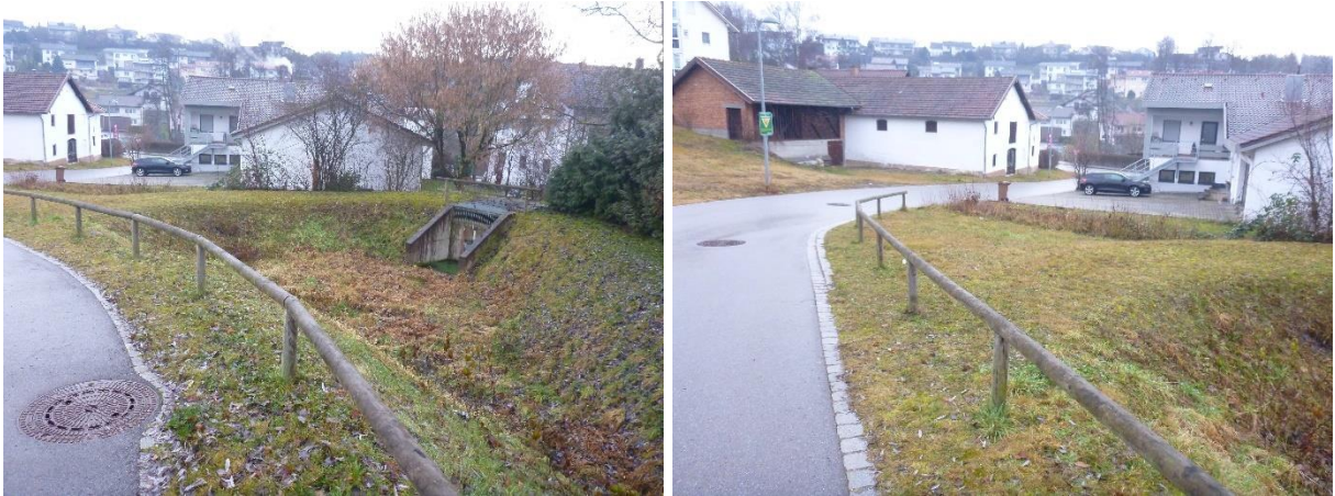
Abbildung 49: RRB12, Becken und Straßenbereich
