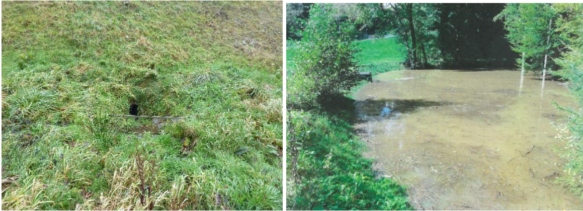
Abbildung 46: Rückhaltebecken RRB10, Falkenstraße, Grundablass links und Einstau bei Hochwasser rechts
