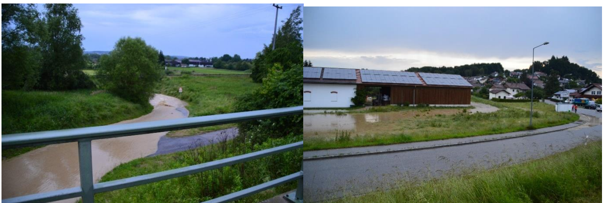
Abbildung 34: links: Hochwasserentlastung Fkm 0,30, rechts: Inselbildung Fkm 0,40
