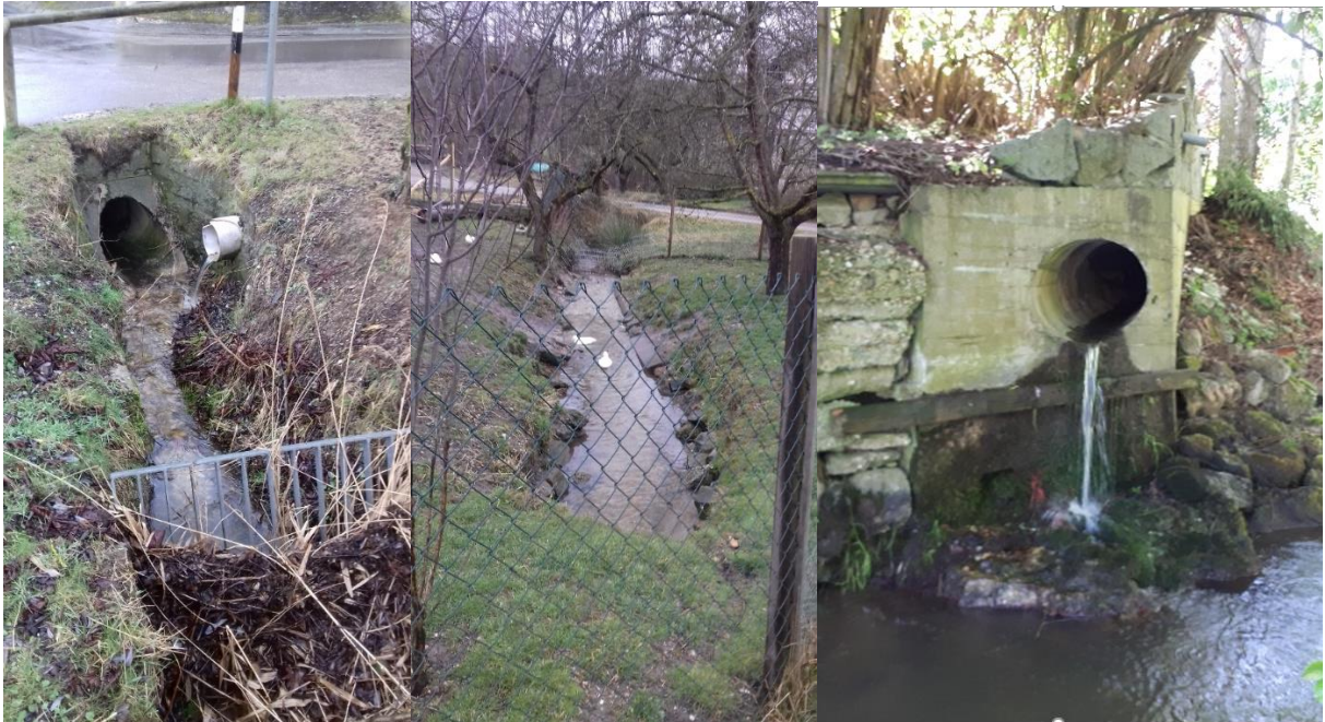
Abbildung 44: Weidenergraben Links: Einlauf Verrohrung Fkm 0,20, Mitte: Offener Bachlauf Fkm 0.80,Rechts: Auslauf in Grasenseerbach
