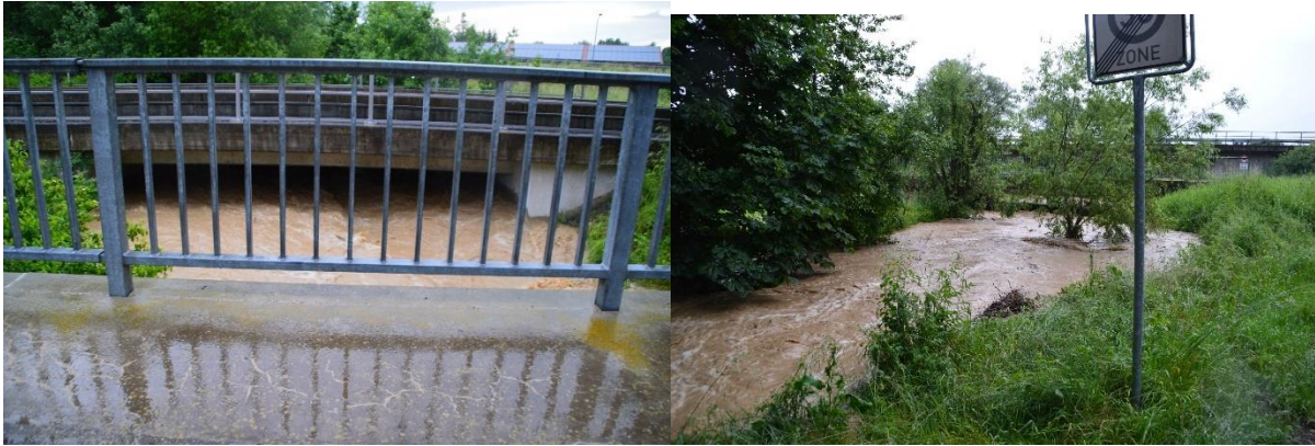
Abbildung 35: Brücke Römerstraße Fkm 0,35 Oberstrom rechts und Unterstrom links.
