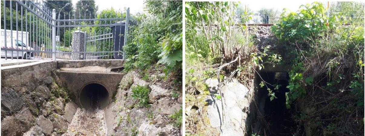
Abbildung 27: Einlauf Schindergraben (links) und Bahndurchlass (rechts)
