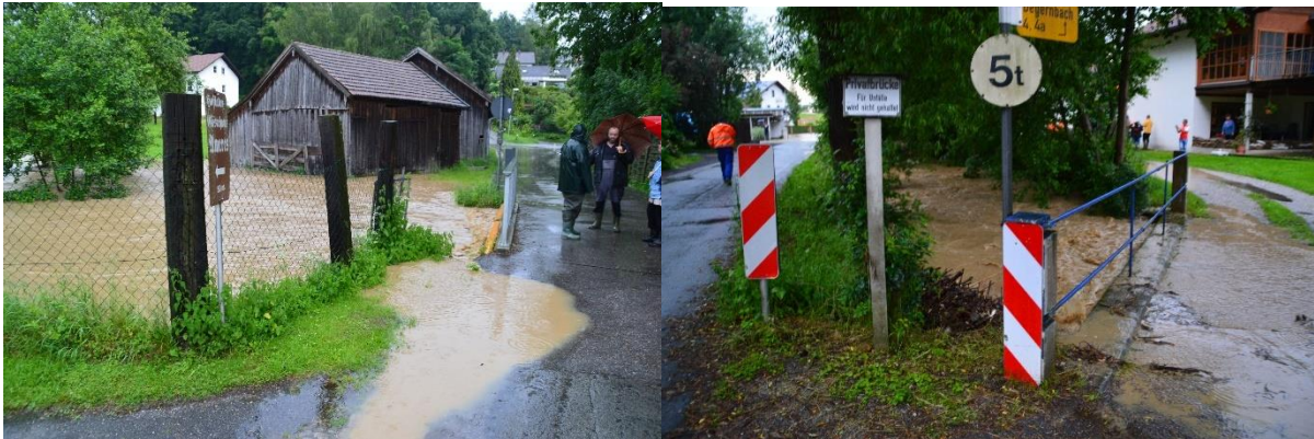
Abbildung 32: links: Brücke Fkm 0,78 Wiesenweg, rechts: Brücke Fkm 0,43 zu Degernbach 2a
