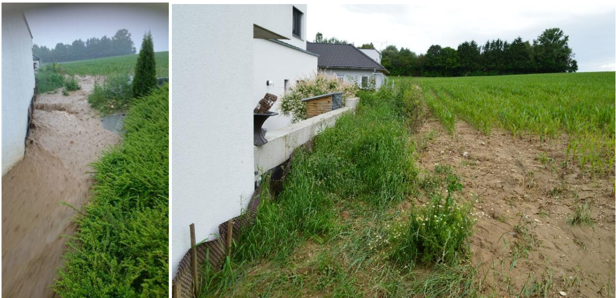
Abbildung 5: Abfluss ins Wohngebiet an der Dr. Adolf Oswald Straße beim Starkregenereignis 2016 in Pfarrkirchen.
