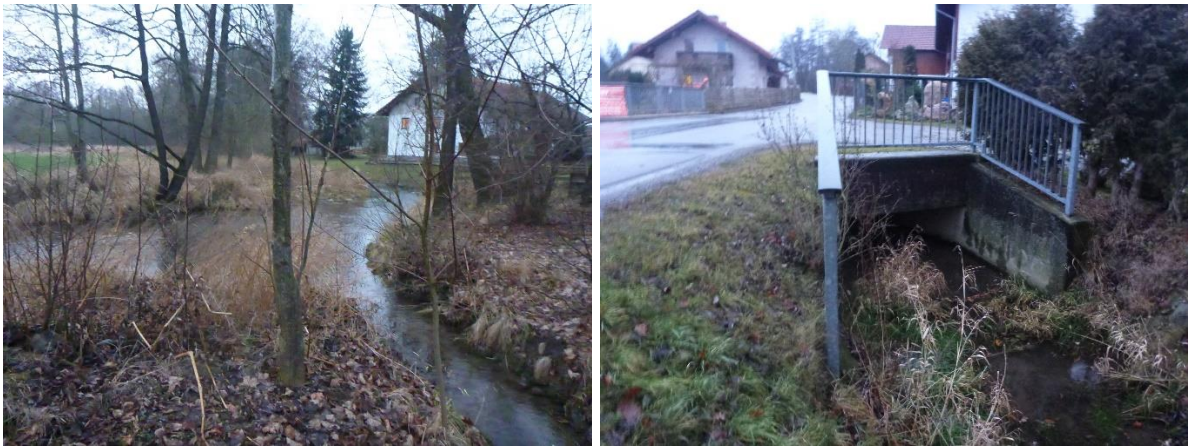
Abbildung 42: Links: Mündung Grasenseerbach, Rechts: Durchlass PAN17 Fkm 0,10
