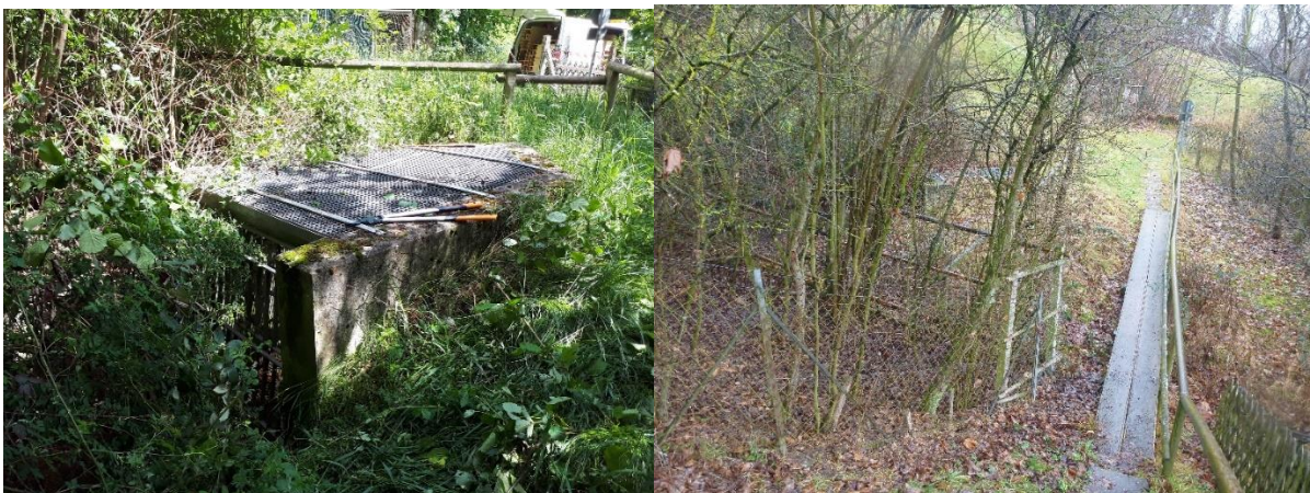
Abbildung 25: Einlaufbauwerk östlicher Zufluss am Schindergraben
