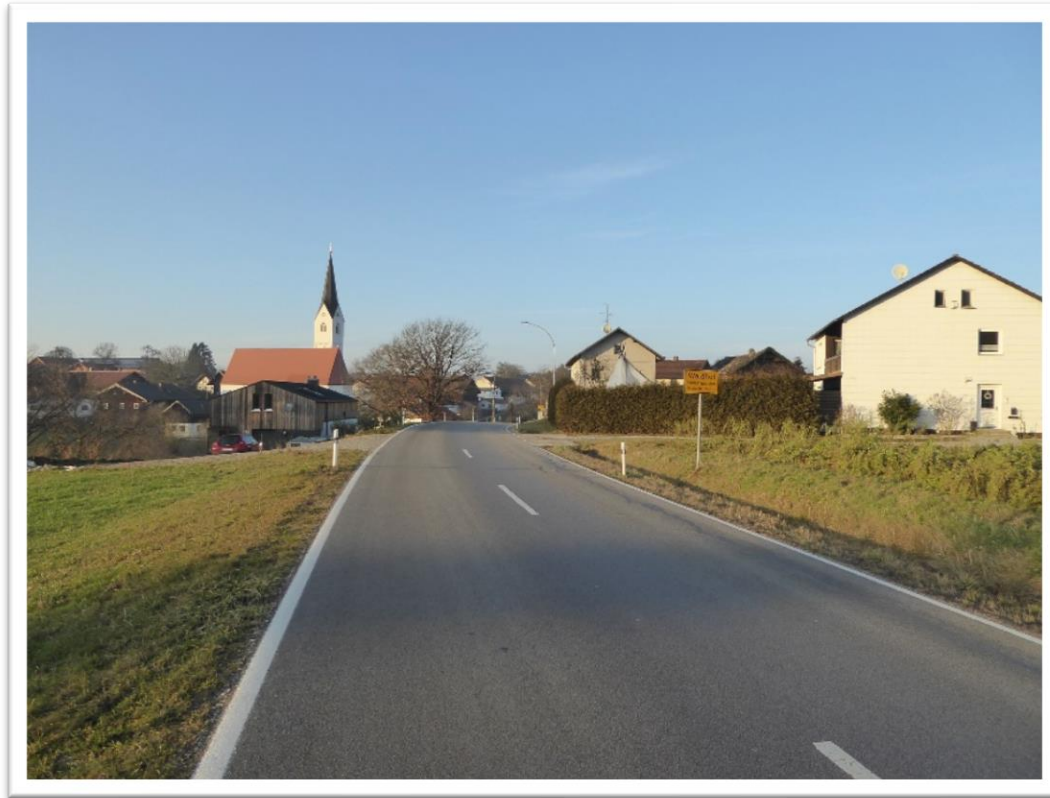
Kreisstraße PAN 16, östliche Dorfeinfahrt
