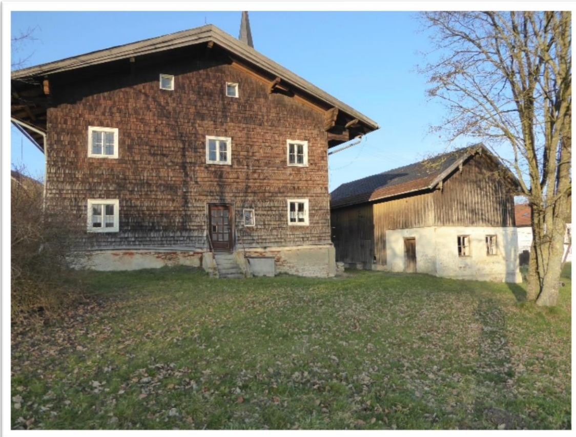
Pfarrhof Waldhof und Nebengebäude von Süden
